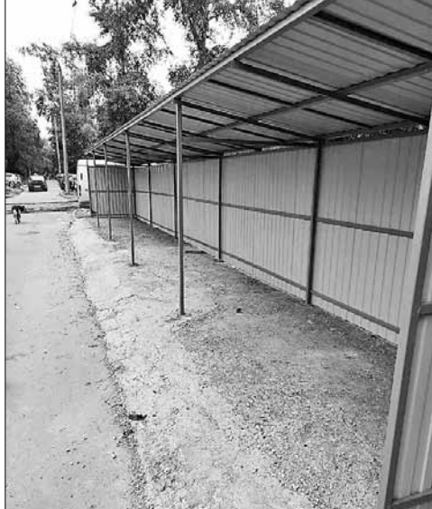
■ Площадка на ул. Тимме, 18
